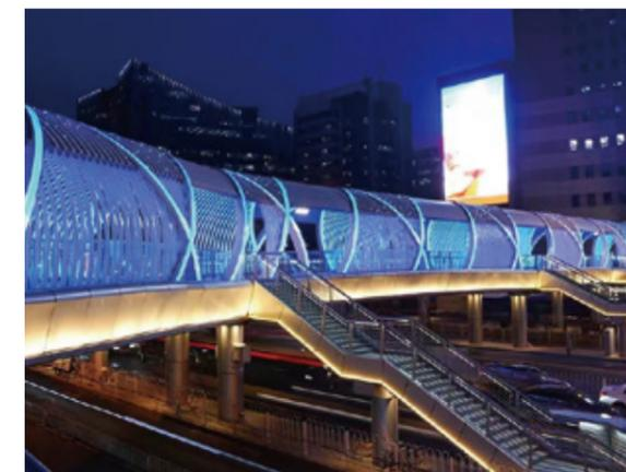
灯光勾勒桥梁轮廓，完美呈现拱桥装饰，营造简洁灵动的桥体形象，桥下部采用大面积泛光灯，展现桥梁的风采和恢弘气魄，桥柱采用投射灯点缀。
