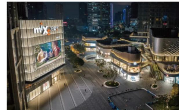
外墙部分疏密布置纵向线条，形成节奏感。同时使用嵌入式线光灯嵌入铝板接缝处，为金属质感渲染上了浪漫的气息，完成“虚”的趣味建构。
