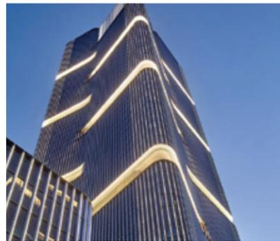
沿整个建筑造型设置的幕墙肋板照明从正面射出光线，这些光线在肋板内部已经经过反射，从而形成了柔和的弥散效果。
