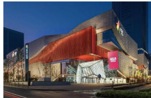
线条灯表现建筑流动变化的视觉形象，通过投光灯对立面进行照明，表现整体建筑的质感和体块关系。
